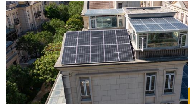
Installation sur le toit d'un bâtiment ancien
