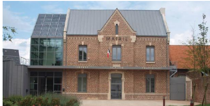
Construction photovoltaïque rapportée
